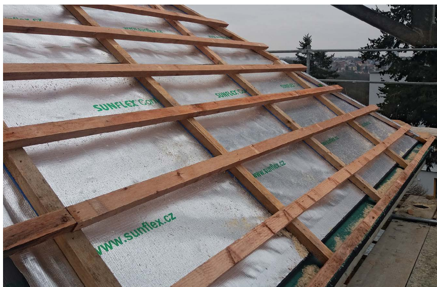
Aplikace reflexní pojistné hydroizolace. Před položením krytiny je potřeba povrch zbavit pilin a nečistot
