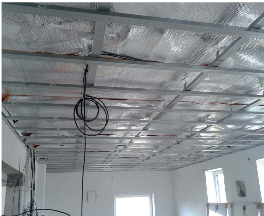
Izolace vzduchové mezery nad stropní konstrukcí, která bude osazena panely stropního vytápění
