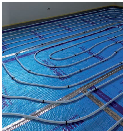
Vysoce odrazivá fólie SUNFLEX® Floor PRO se 6,5mm silnou vzduchovou mezerou
