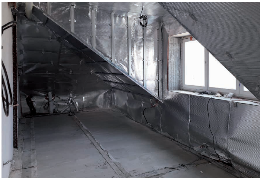
Termoreflexní parozábrana SUNFLEX® Roof-In PLUS eliminuje sálavý přenos tepla ve vzduchové mezeře pod sádrokartonem
