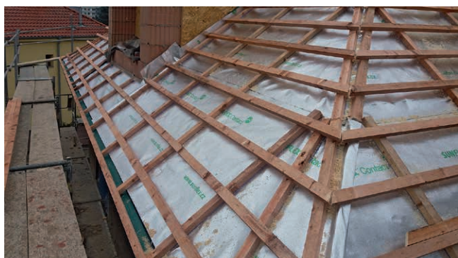
Superdifúzní reflexní fólii SUNFLEX® Contact PRO použita při rekonstrukci vily na Hanspaulce
